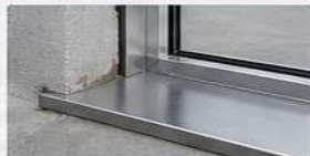
Étanchéité des joints de seuils
