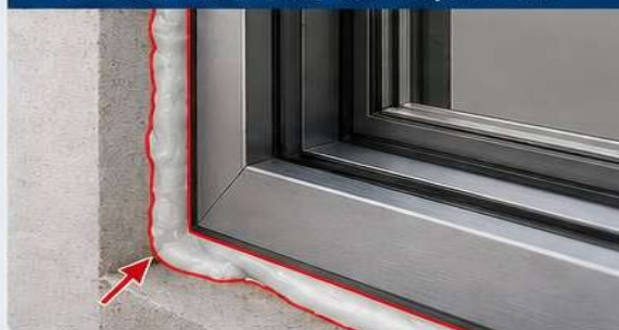
ÉTANCHÉITÉ DES JOINTS DE SEUILS
