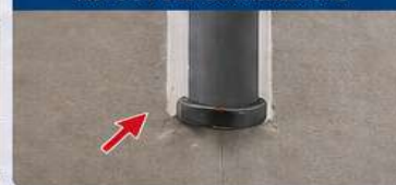
ÉTANCHEITÉ DES JOINTS AUTOUR DES CANALISATIONS
